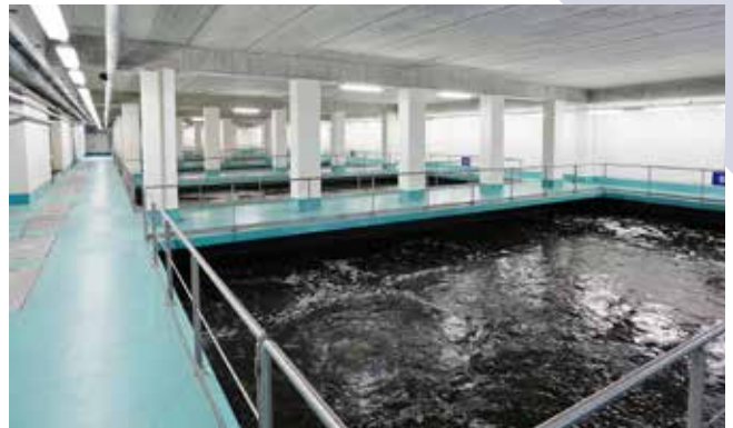
Planta de tratamiento de aguas residuales en Ginebra
