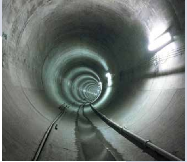
Túnel de aguas residuales
