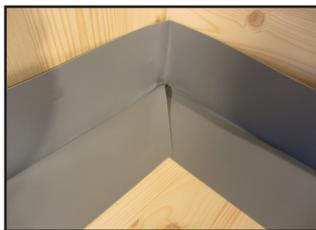
Cortar la banda hasta la mitad y ajustarla a la esquina interior; solapadura: > 2 cm, cortar el resto
