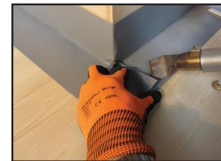
Calentar las superficies de la banda con pistola de aire caliente y apretarlas, comenzando en la esquina hacia afuera
