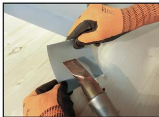
Cortar un trozo de banda suplementario; calentar una esquina con pistola de aire caliente, tirarlo un poco y ...
