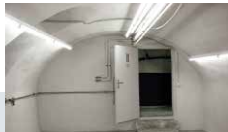
6 Nach Abschluss der Sanierung
