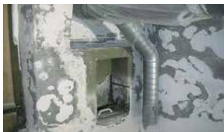
1 Zustand vor Sanierung
