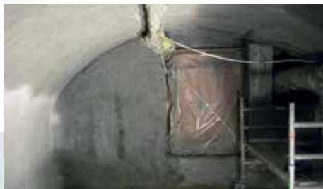
5 Zweite Schicht; VANDEX SANIERPUTZ WTA weiss
