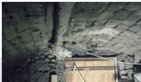
4 Erste Schicht; VANDEX UNIMÖRTEL
