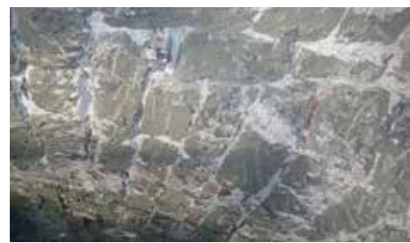
3 Schadhafter Putz ist entfernt
