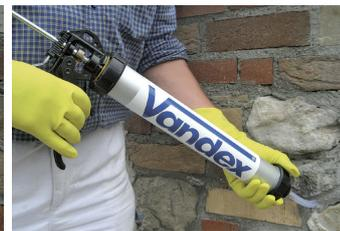
**3.** Eine geeignete Verlängerungsdüse entsprechend der Bohrlochlänge aufsetzen.
