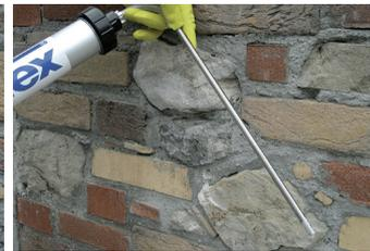
**2.** Schlauchbeutel VANDEX IC 600 ml in Handpistole einführen und öffnen.
