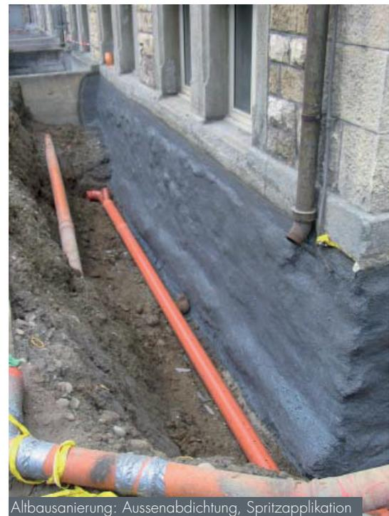
Altbausanierung: Aussenabdichtung, Spritzapplikation
