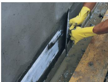
3. Überdecken des Konstrubandes mit der zweiten Schicht VANDEX BB 75 E oder VANDEX CEMELAT ( $2 \text{ kg/m}^2$ , 1 mm) und Oberfläche mit nassem Pinsel abglätten.
