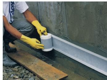
2. VANDEX KONSTRUBAND umgehend in die frisch applizierte Schicht VANDEX BB 75 E oder VANDEX CEMELAST verlegen, anschliessend beidseitiges Einarbeiten der Vliesränder in die Dichtungsschlämme.
