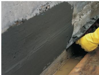
1. Erste Schicht VANDEX BB 75 E oder VANDEX CEMELAST ( $3 \text{ kg/m}^2$ , 1,5 mm, Mischanleitungs. Datenblatt), mindestens 1 cm über VANDEX Konstruband hinaus verlegen.
