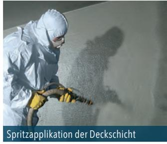
Spritzapplikation der Deckschicht
