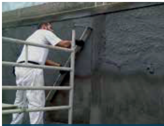
Egalisieren der Ausgleichsschicht
