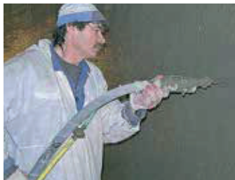
Spritzapplikation der Deckschicht
