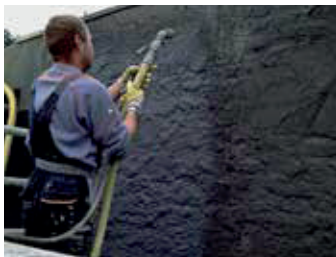
Spritzapplikation der Ausgleichsschicht
