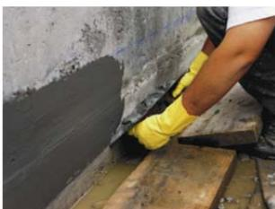
**1.** Préposer la première couche de VANDEX BB 75 E (3 kg/m<sup>2</sup>, 1,5 mm, instructions de mélange: cf. fiche technique VANDEX BB 75 E), en débordant au moins d'1 cm de la bande VANDEX CONSTRUCTION JOINT TAPE.
