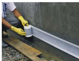
**2.** Immédiatement après, poser la bande VANDEX CONSTRUCTION JOINT TAPE dans la couche fraîche de VANDEX BB 75 E, maroufler ensuite les deux côtés des bords du non-tissé dans le coulis d'étanchéité VANDEX BB 75 E.
