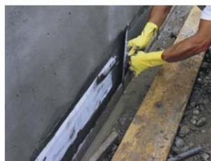
**3.** Recouvrir la bande VANDEX CONSTRUCTION JOINT TAPE d'une seconde couche de VANDEX BB 75 E (2 kg/m<sup>2</sup>, 1 mm) et lisser la surface au pinceau humide.
