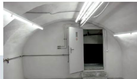
6 Nach Abschluss der Sanierung
