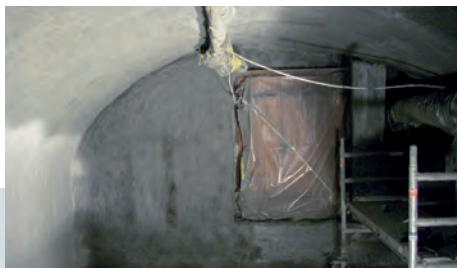
5 Zweite Schicht; VANDEX SANIERPUTZ WTA weiss
