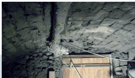
4 Erste Schicht; VANDEX UNIMÖRTEL
