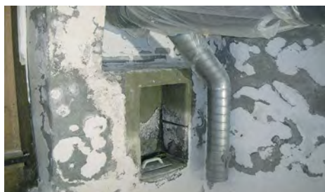
1 Zustand vor Sanierung
