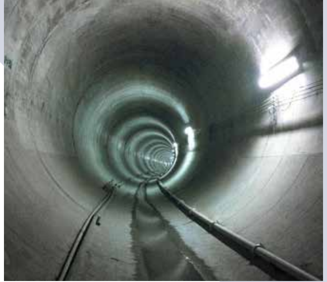
México: Túnel de aguas residuales
