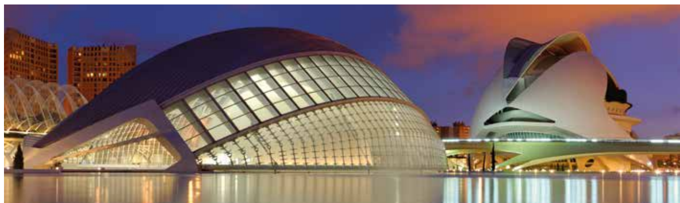
Calatrava's Palacio de las Artes - Valence, Espagne
